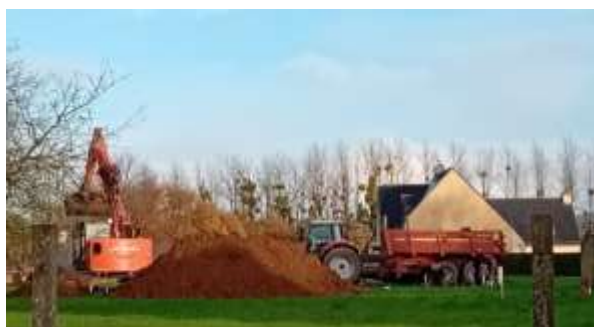
Construction de la 1 ère maison dans le lotissement. Le lot n°4
