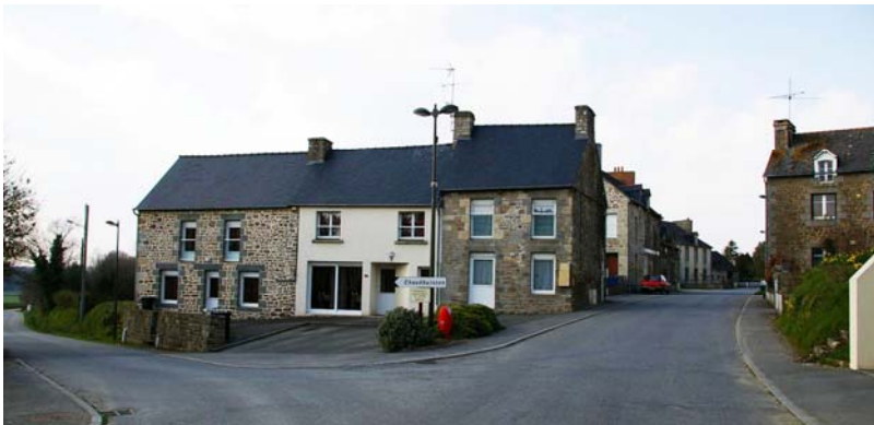
Vue sur un édifice divisé en plusieurs habitats. Cette reconversion a permis d'utiliser le volume à disposition pour y introduire des habitats de tailles différentes.
