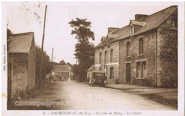
Fig. 19 Vue du Châbre 1937 et aujourd'hui Source : site camasipa et photo auteur
